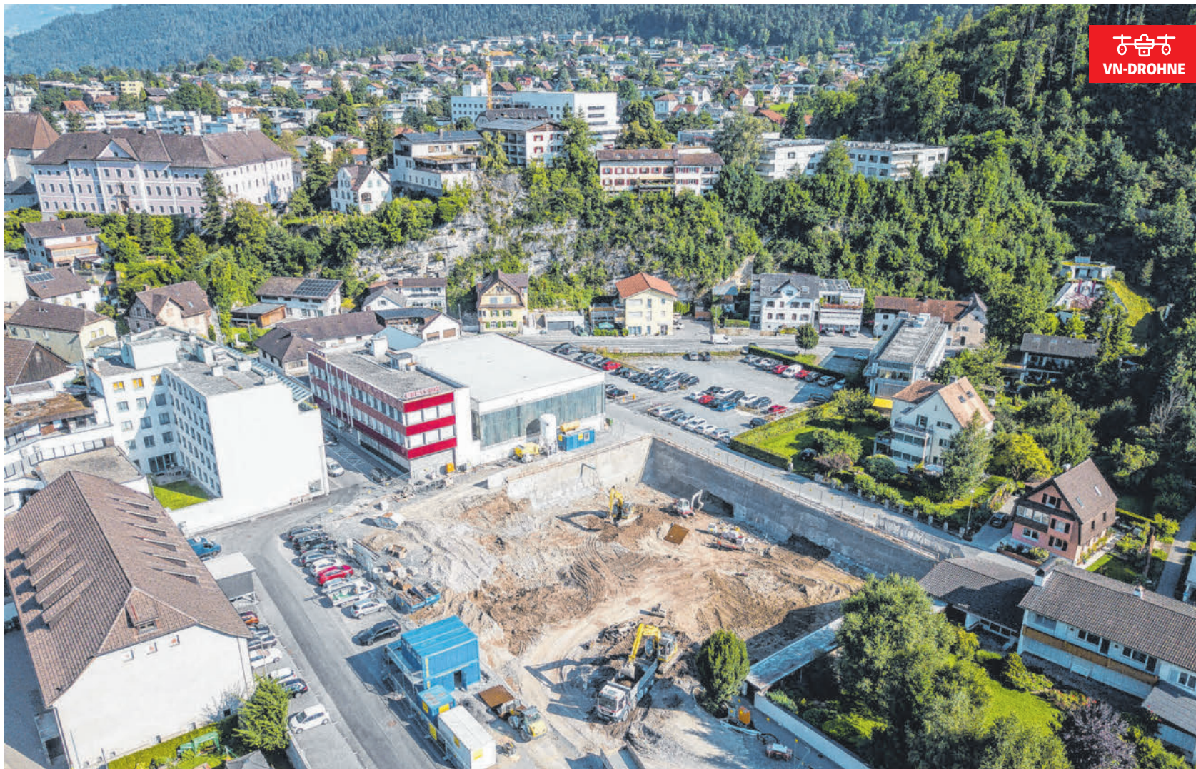
Auf dem einstigen Viehmarktgelände in Bludenz entsteht in den nächsten zwei Jahren der neue Firmensitz der Firma Jäger Bau.
