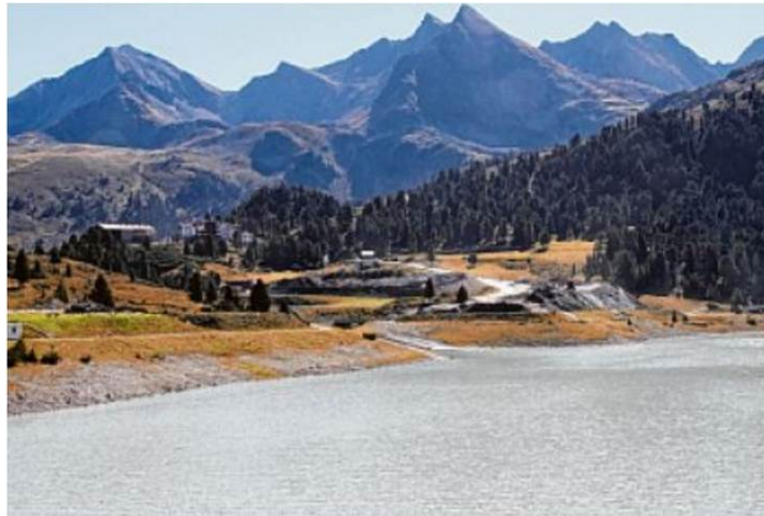
Die Vorbereitungsarbeiten für Speicher und Kraftwerk „Kühtai 2“ laufen bereits. Infomaterial ist auf www.erneuerbareplus.at zu finden. Foto: Parth
