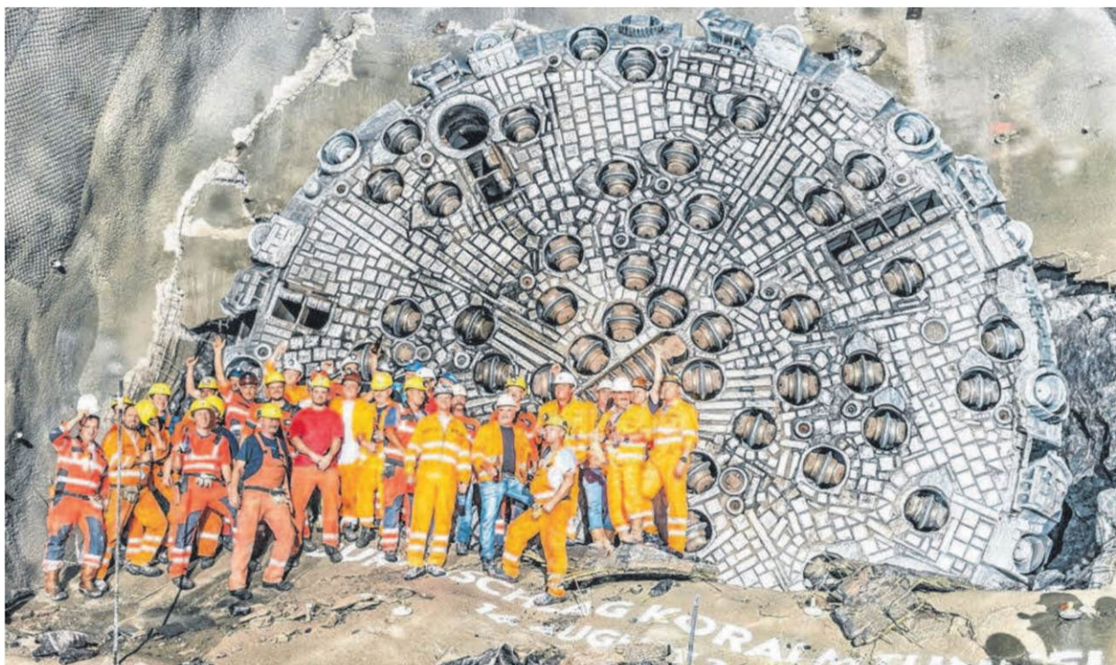
Die Tunnelbau-Spezialisten von Jäger Bau hatten nach dem Durchschlag im Koralmtunnel Grund zum Feiern.
