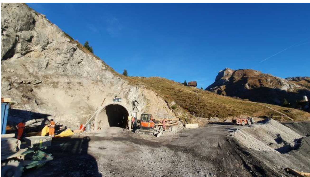
Portal zum Zugangsstollen, im Hintergrund die Hütte, in der Bauleiter Christoph Sinkovec den Winter verbracht hat und wo auch schon der Bauleiter vor 100 Jahren gewohnt hat.
