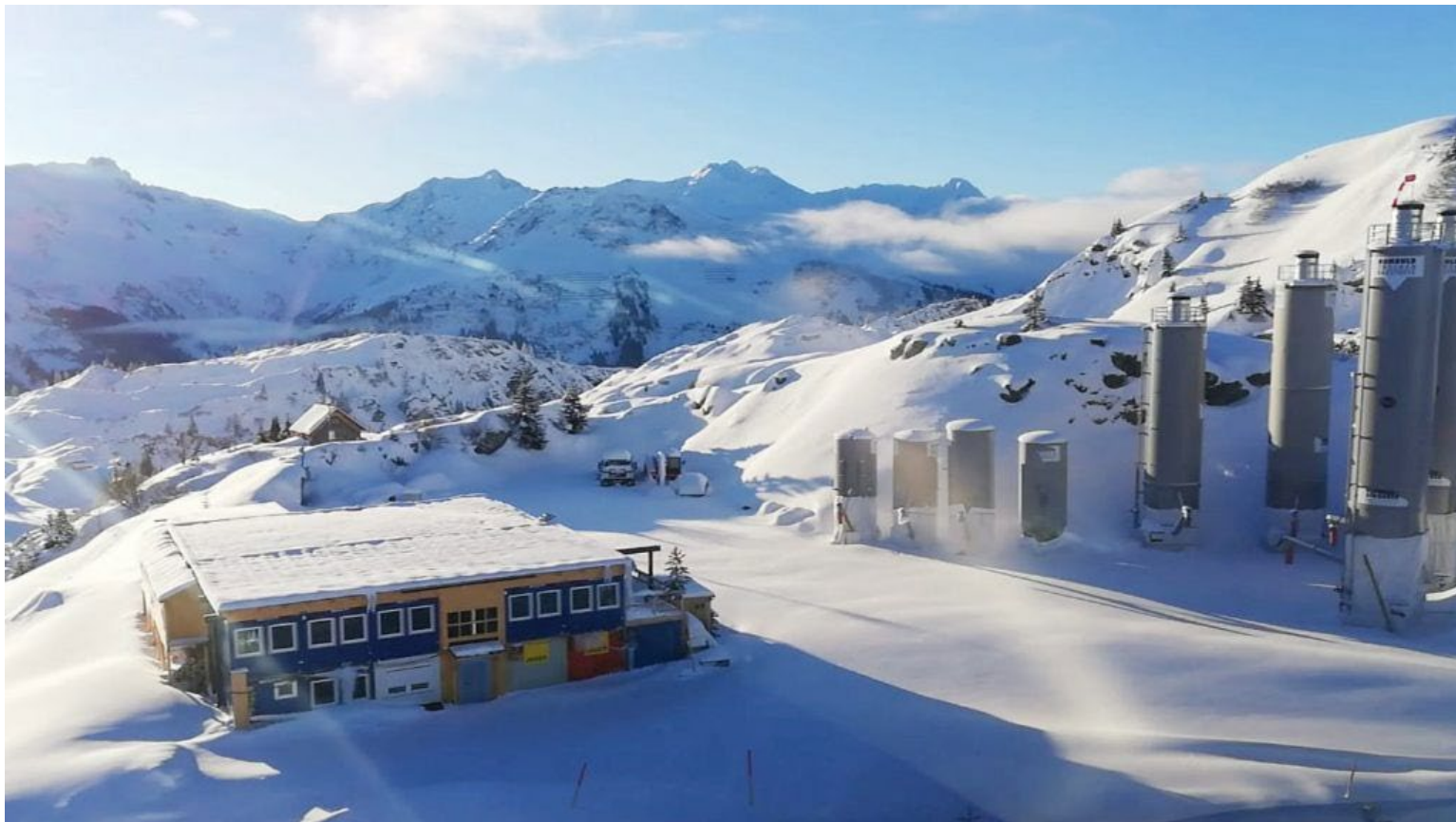
Baustelleneinrichtung für die Sanierung des ÖBB-Kraftwerks Spullersee.
